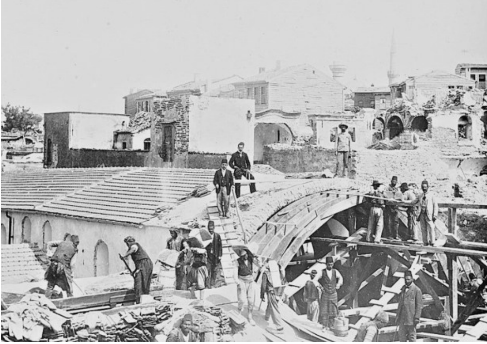
1894 depremi sonrasında Kapalı Çarşı'da Kalpakçılarbaşı Caddesi kemerlerinin tamiri, sene 1896.
